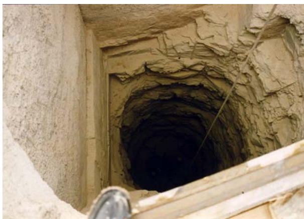
Slika 14. Ulaz u kabelsko okno 1 na lokaciji GMPS 1 (dubina okna 140 m, vanjski promjer 3 m); pogled na ulaz u okno
