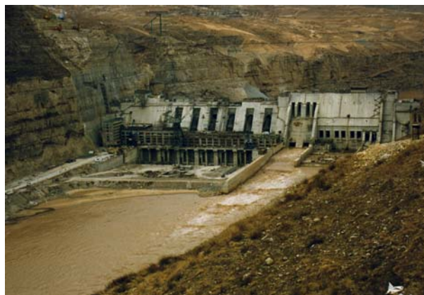
Slika 4. Betonska derivacijska brana na Žutoj rijeci u blizini Wanjiashajia
