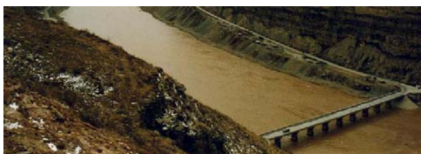
Slika 5. Pogled na Žutu rijeku i most Wanjiashai s lokacije GMPS1 nizvodno od derivacijske brane Wanjiashai
